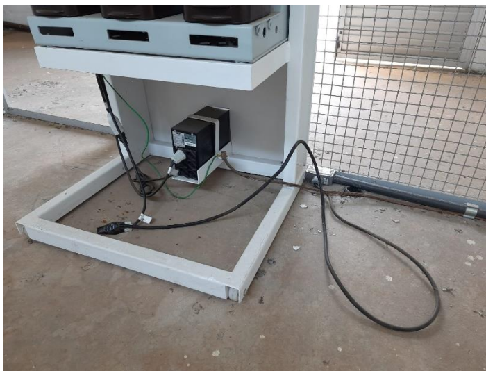
Figura 2: Conexão de serviço auxiliar com nobreak.
