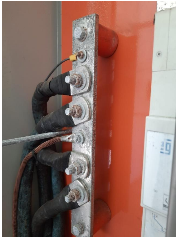
Figura 9: Estado dos barramentos e parafusos de entrada do disjuntor de QGBT.
