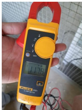
Figura 3: Tensão de fornecimento de TP de serviço auxiliar.
