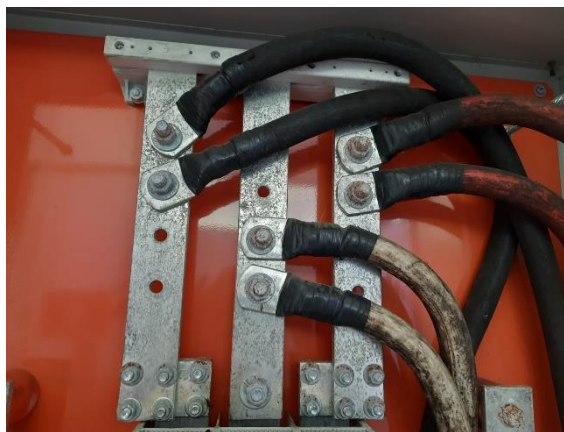
Figura 9: Estado dos barramentos e parafusos de entrada do disjuntor de QGBT.
