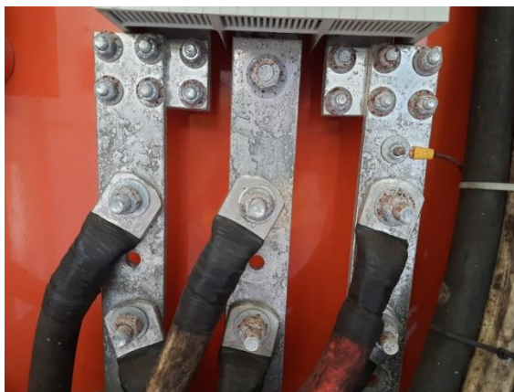
Figura 7: Situação dos barramentos e barramentos de saída do disjuntor de QGBT.
