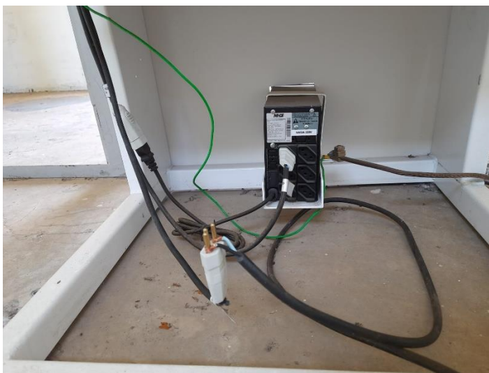
Figura 2: Conexão de serviço auxiliar com nobreak.
