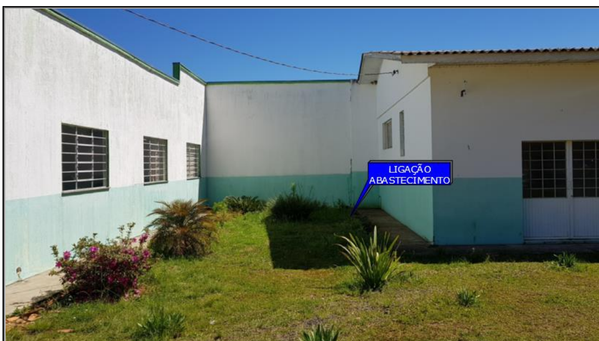
Figura 20. Ponto de ligação para distribuição da água.
