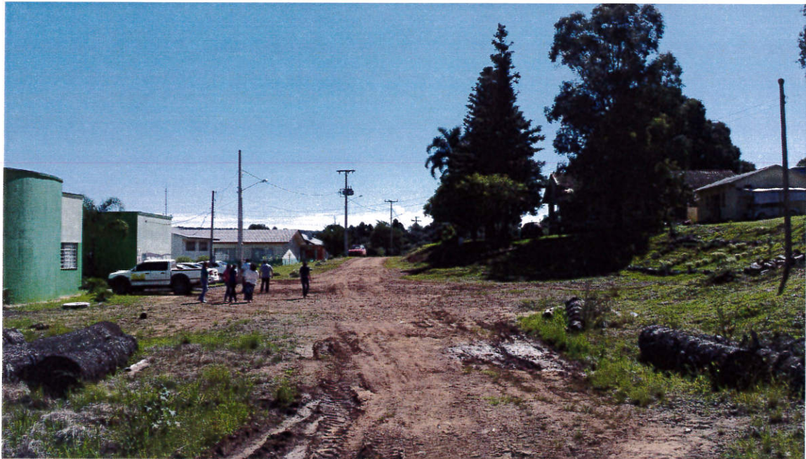
Fotografia 02: Acesso ao local da construção
