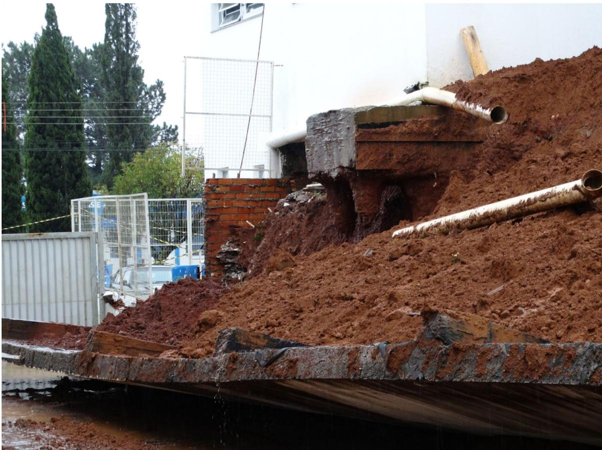
**Figura 1:** Exposição das fundações da torre da caixa de água.
