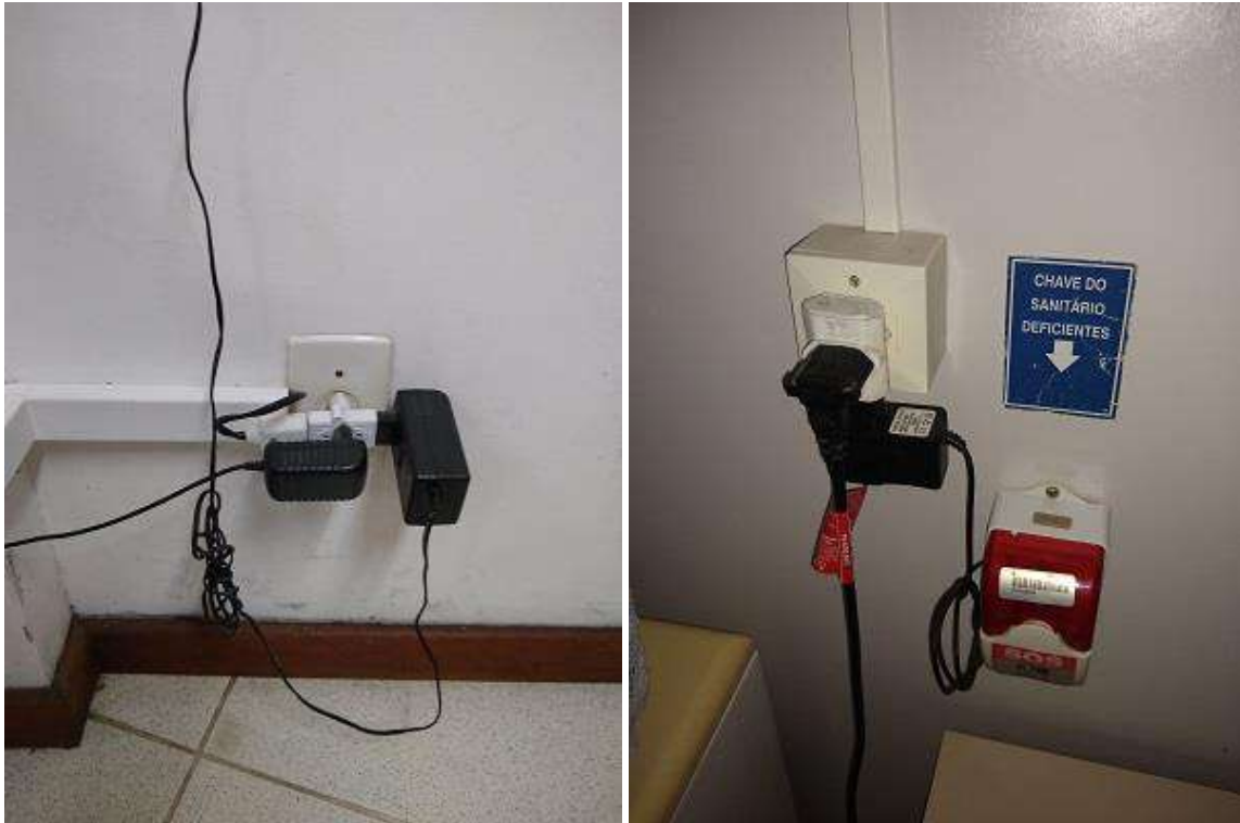
Figura 43 – Tomadas com adaptadores tipo “T”.
