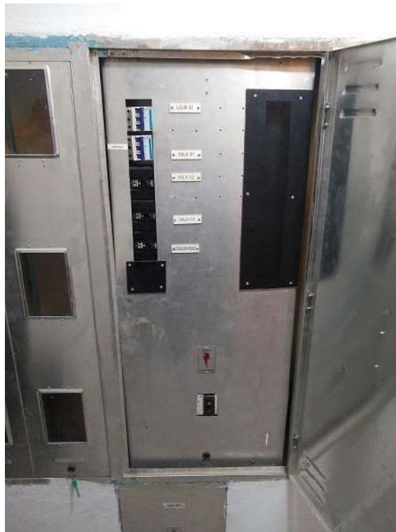
Figura 3 – Chapa metálica para proteção contra contato direto.
