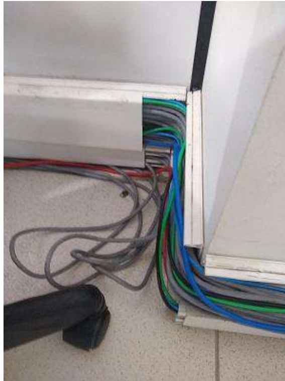
Figura 52 – Sistema de potência e dados compartilhando a mesma canaleta e com ocupação além do limite.
