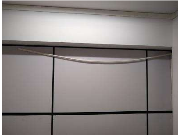
Figura 48 – Canaleta solta.
