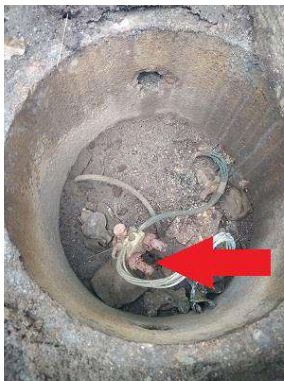
Figura 3 – Conector oxidado.
