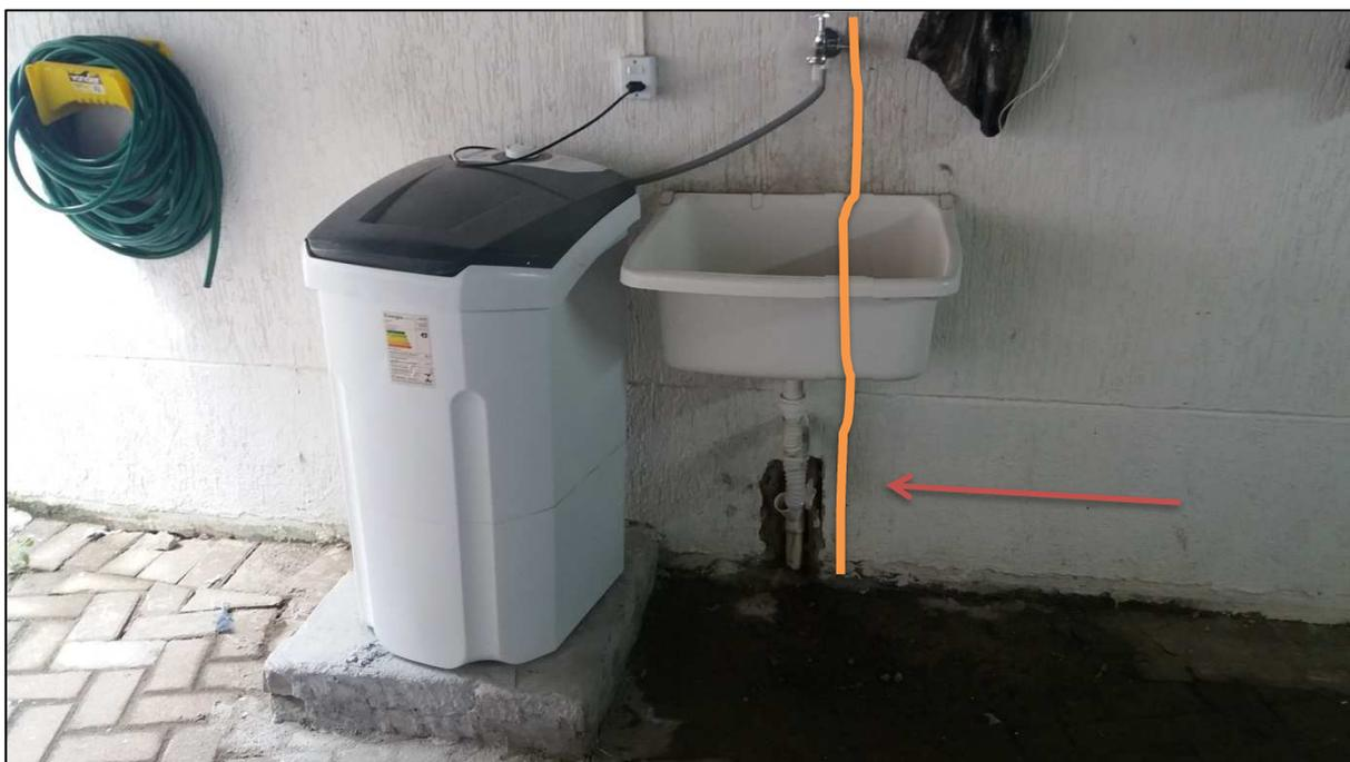
Figura 3 – Posição estimada de prumada de esgoto da copa.
