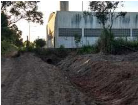
Saída Drenagem.jpg 469K
