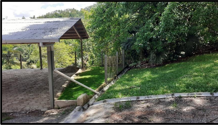
Drenagem superficial do pátio interno conduzida para o talude do muro.
