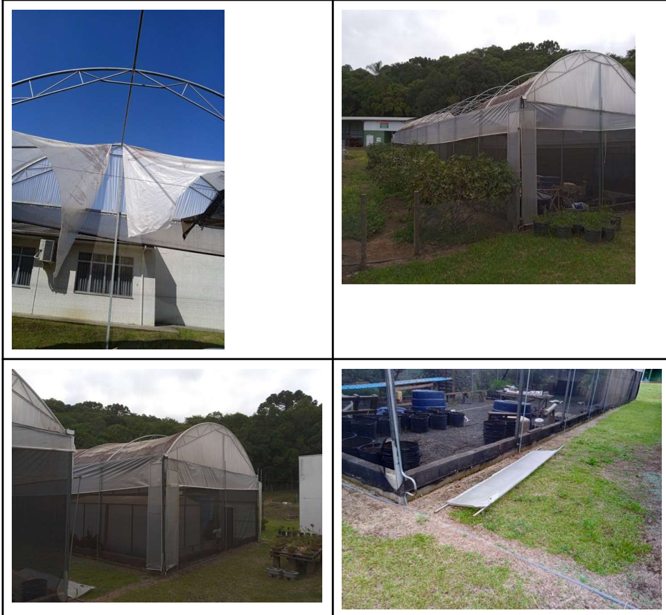
Figura 3 - Situação do filme plástico das estufas.
