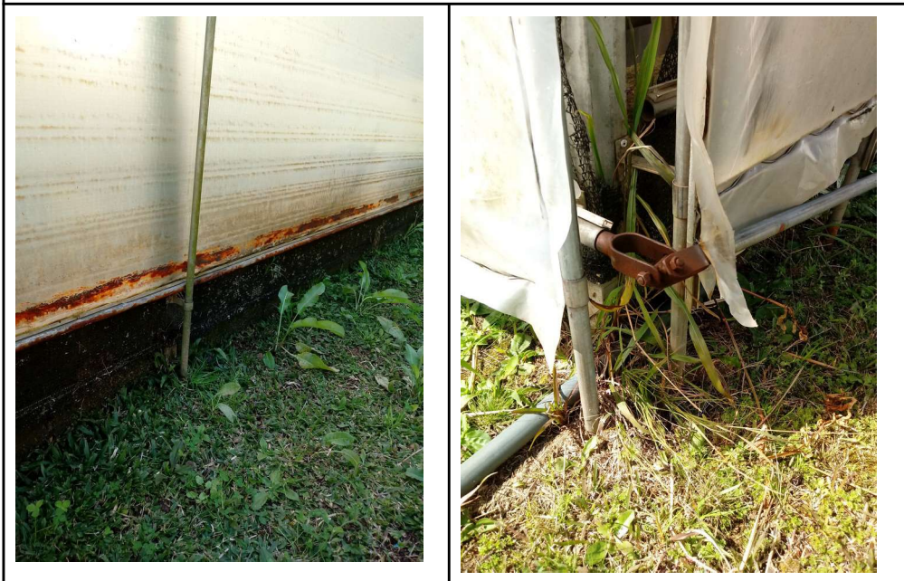
Figura 1 - Situação das barras e das manivelas e cruzetas das cortinas.
